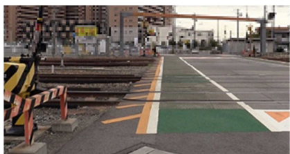
写真3 踏切の歩道の例
