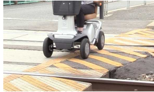
写真7 路面標示上を走行している間違った通行
